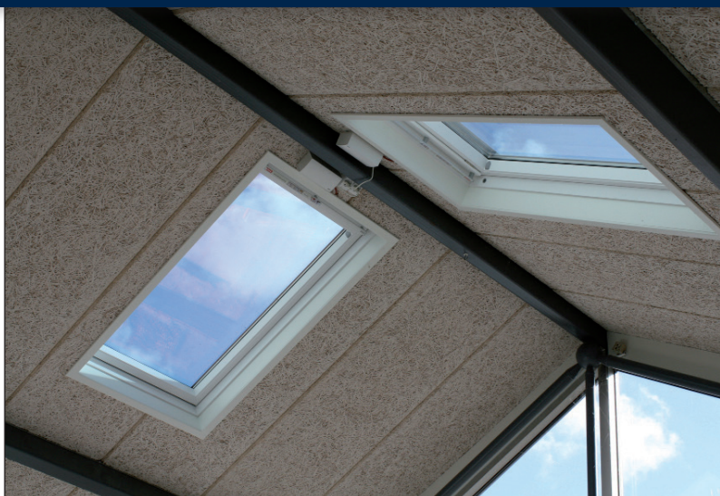
Velux med komfortventilation indbygget i DPC ISOTEC TT Tagelement.
